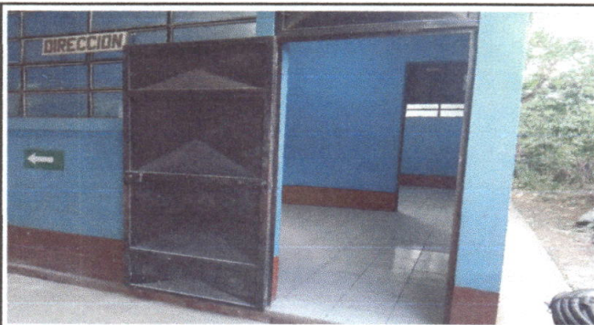
Foto 9: Remozamiento finalizado del piso alisado a piso ceramico direccion y bodega.
