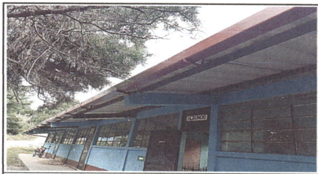
Foto 12: Remozamiento finalizado de canales lineales de 4 aulas, direccion y cocina.
