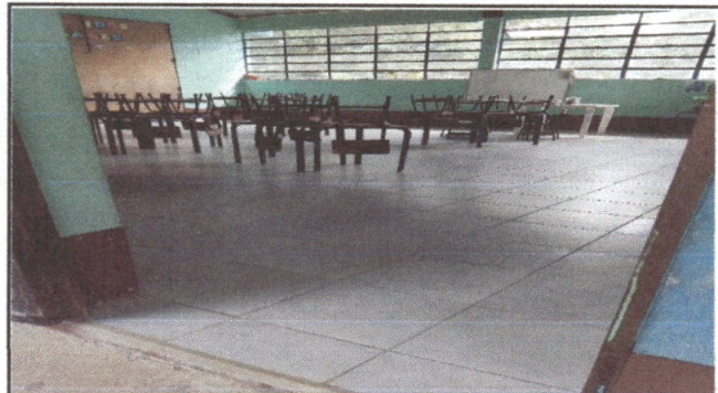
Foto 8: Remozamiento finalizado de piso alisado a piso ceramico de 4 aulas
