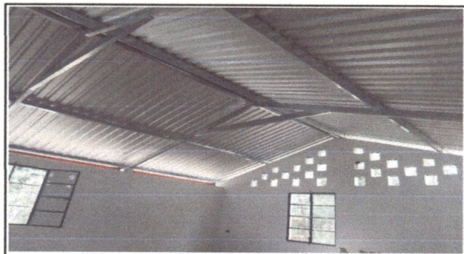
Foto 10: Remozamiento finalizado estructura de techo de madera a estructura metálica de la cocina y su corredor.
