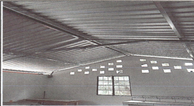
Foto 7: Remozamiento finalizado del sistema electrico de la cocina.
