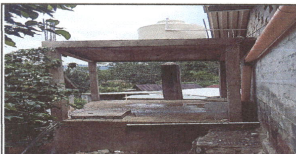
Foto 6: finalización de cisterna con tinaco arriba, detrás de la cocina.
