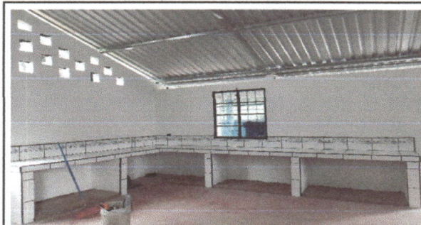
Foto 1: Finalización de implementación de 3 pestañas lineales tipo desayundador dentro de la cocina, cementadas y con azulejo.
