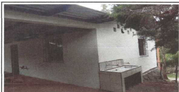
Foto 5: Remozamiento finalizado de pared exterior de la cocina.
